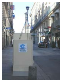
Photo 1 : Armoires rue Crébillon
