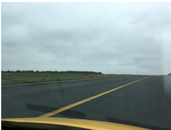
Site n°11 : travaux d'enrobée sur le taxiway, et la bretelle sud d'accès à la piste
