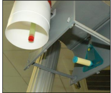
Tubes installés pour la collecte
