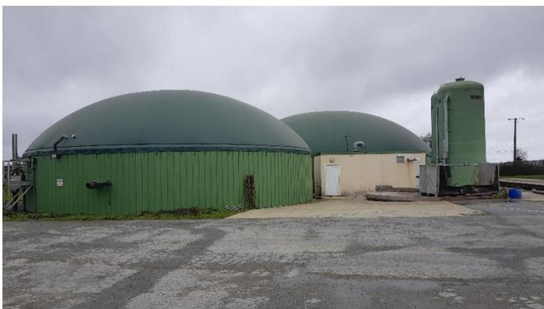
Figure 3 : post-digesteur (à gauche) et digesteur (à droite)
