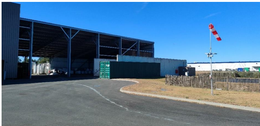
Figure 2 : bâtiment de réception (partie substrats peu odorants)
