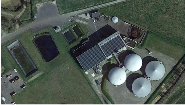
Vue aérienne de la Centrale Biogaz des Terres de Montaigu
