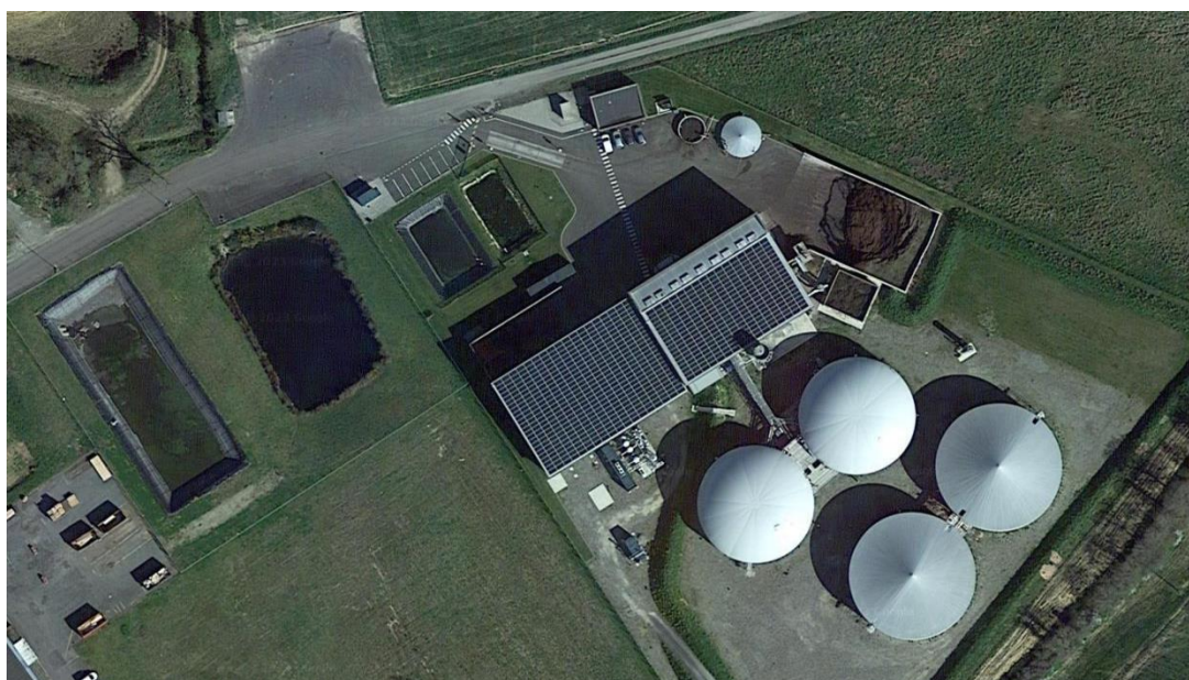
Figure 1 : vue aérienne de la Centrale Biogaz des Terres de Montaigu
