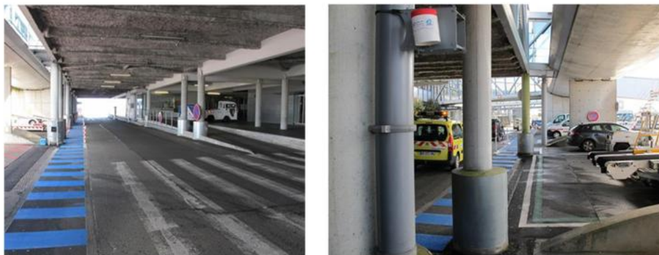
Typologie du site n°13 – confinement de la zone et circulation des véhicules des services de l'aéroport
